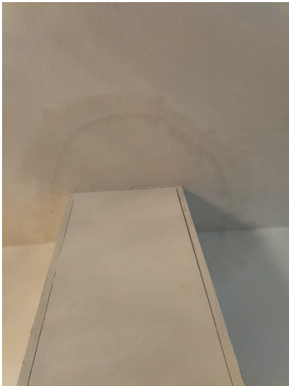
Afbeelding 23: oude lekkage bij een standpijp.
