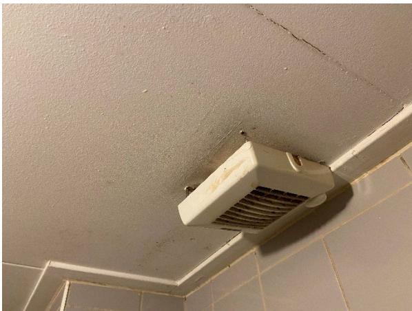
Afbeeldingen 15, 16, 17, 18, 19 en 20: Sterke schimmelvorming en ventilatoren die onvoldoende functioneren of opgehangen zijn. Ventilatoren die niet na-blazen of los zijn gekomen.
